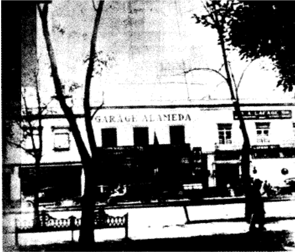
Garaje Alameda , ubicado en Avenida Juárez 62, frente a la Alameda Central de la Ciudad de México. Foto del Archivo Felipe Gálvez Cancino. 62
