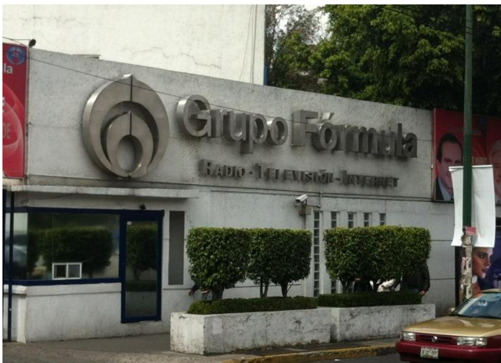
Instalaciones de Grupo Fórmula Coyoacán en avenida Universidad 1273, la antigua casona donde se encontraba Discos Orfeón .
